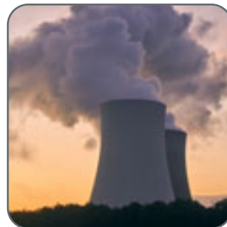
Kraftwerk und Rückbau
